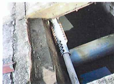
水漏れ箇所修理の様子
